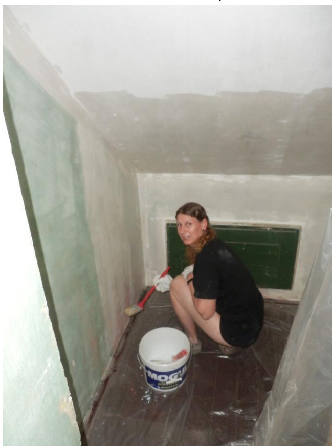
Malování vnitřních prostor
