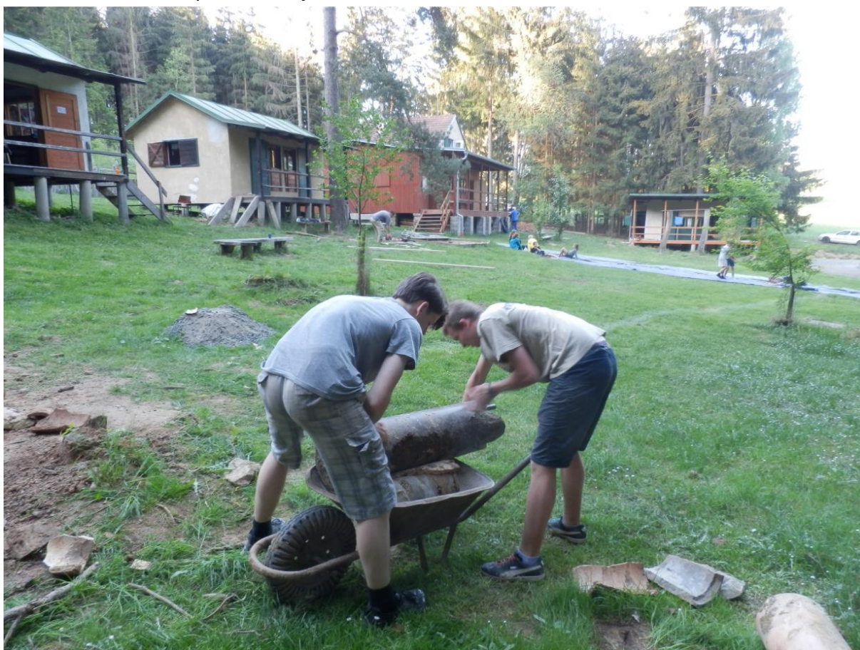
Práce na opravě vodovodní přípojky
