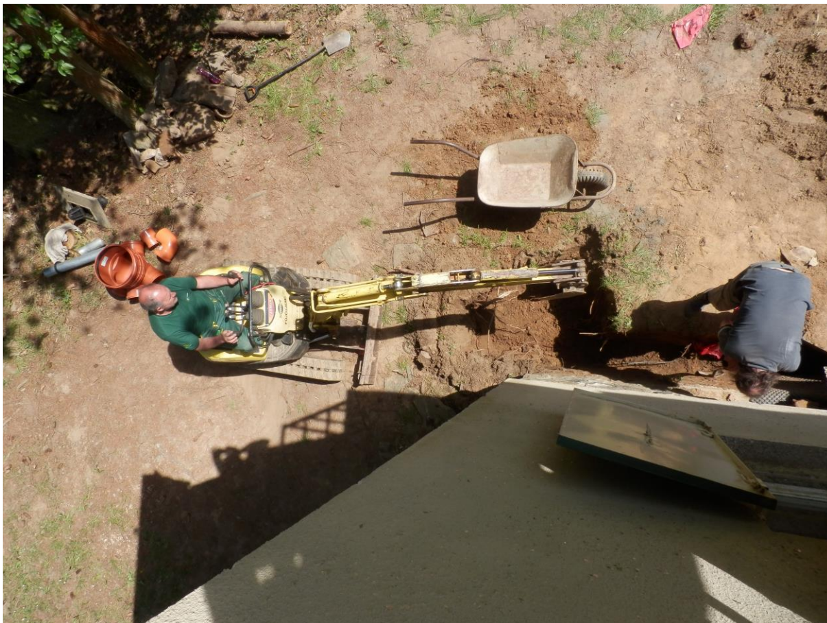
Práce na odvlhčení hlavní budovy
