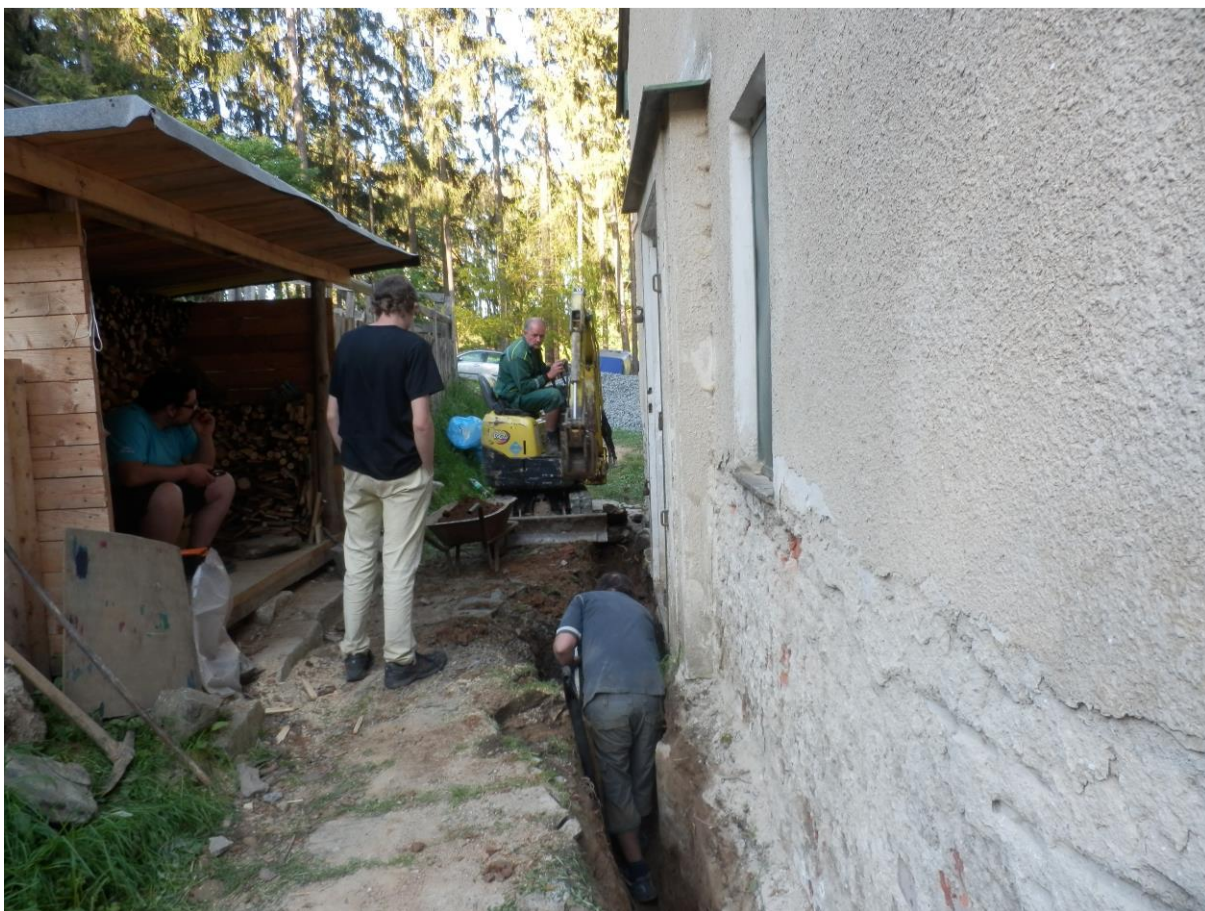
Práce na odvlhčení hlavní budovy
