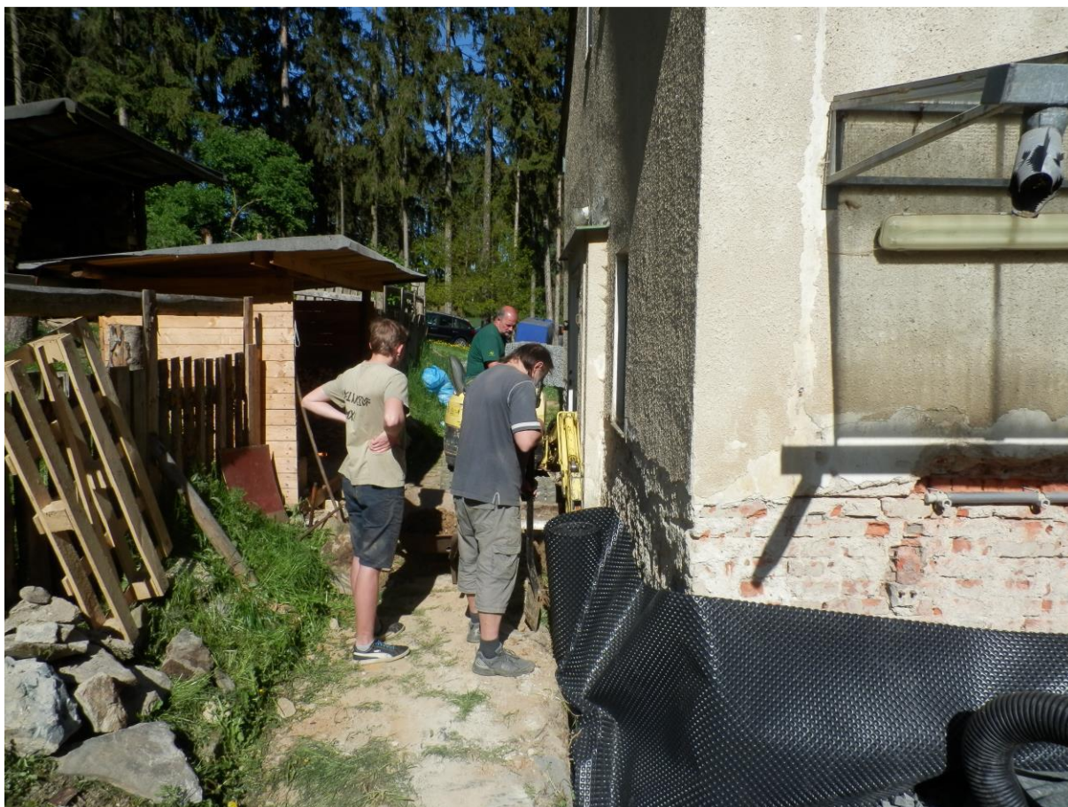
Práce na odvlhčení hlavní budovy
